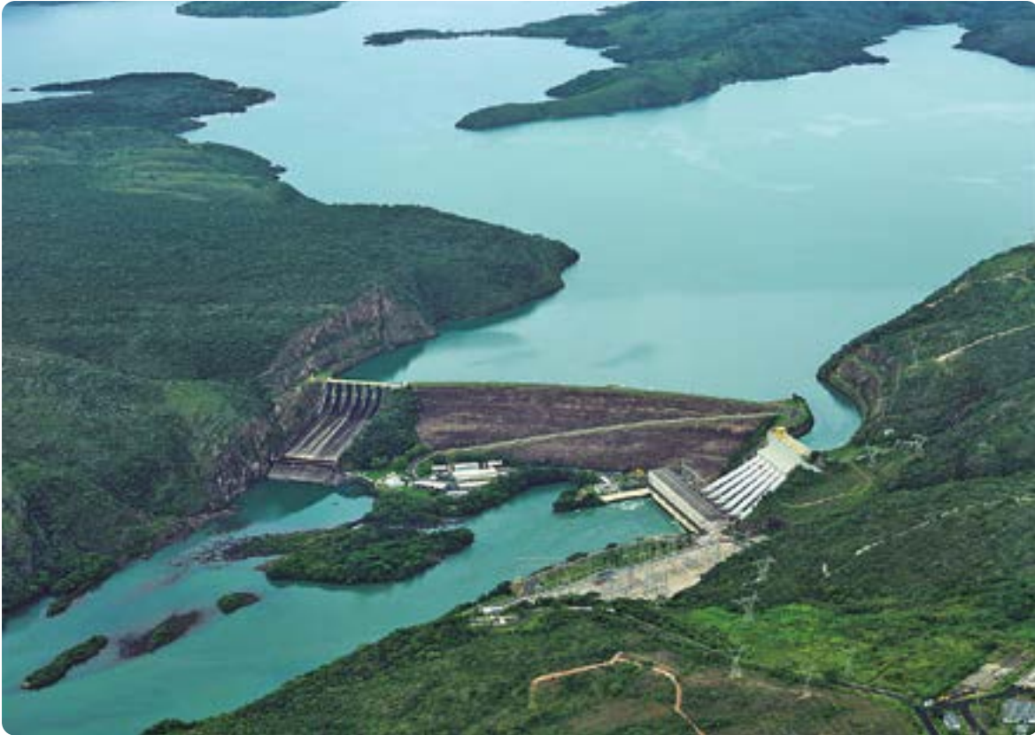
Barragem da Usina Hidrelétrica de Estreito (UHE Luiz Carlos Barreto de Carvalho) no Rio Grande, na divisa entre Pedregulho (SP) e Sacramento (MG).
