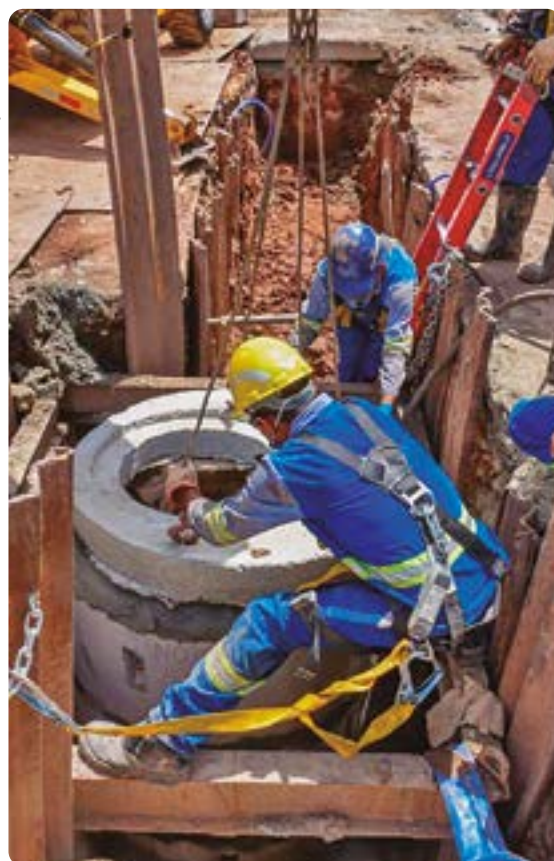
Obras de ampliação da rede de esgoto em bairros do município de Presidente Epitácio (SP).
